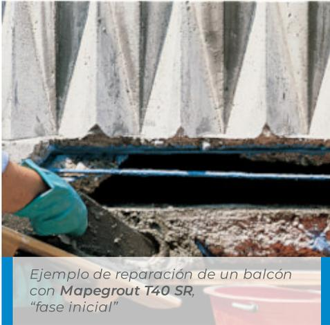
Ejemplo de reparación de un balcón con **Mapegrout T40 SR**, "fase inicial"
